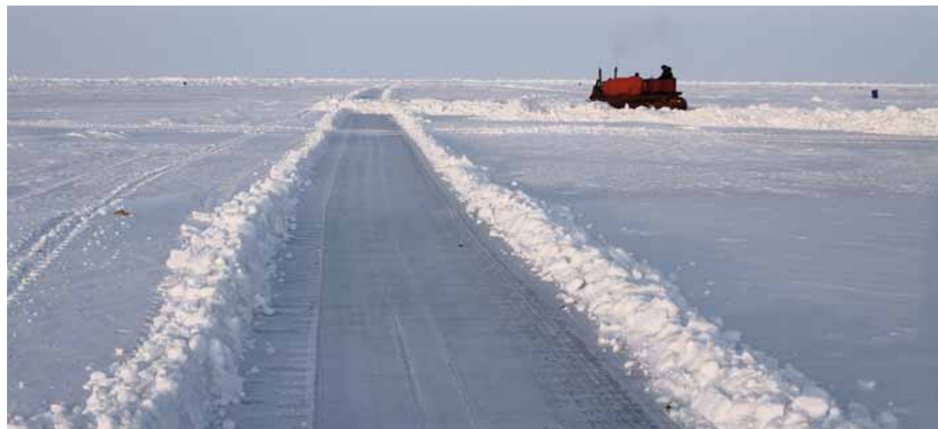
Kaum sind die Kettentraktoren ausgepackt und funktionstüchtig, beginnt die Arbeit: Die Landepiste wird planiert.
